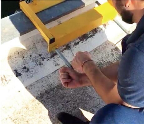
*Pegue a base fixadora (07), e ancore onde vai ser levantado o elevador (verificar se onde vai ser fixado tem condições de suportar o peso do içamento do elevador).*
